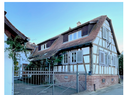
5.59 Saniertes Haus in Lengfeld (Otzberg)
