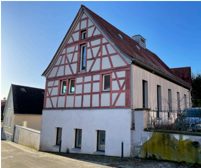
5.77 Sanierung und Teilneubau in Roßdorf
