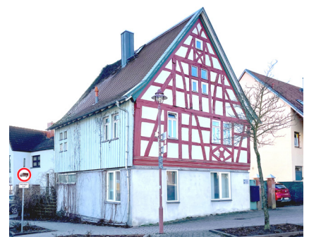
5.29 Saniertes Fachwerkhaus in Roßdorf
