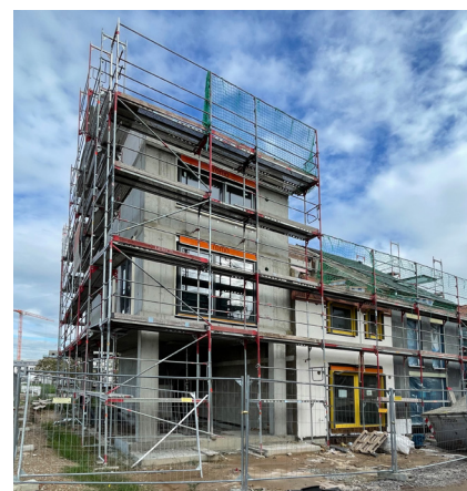
6.25 Sichtbare Betonbauteile eines Neubaus
