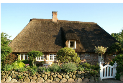
5.49 Norddeutsches Backstein-Reetdachhaus (Nordfriesland)
