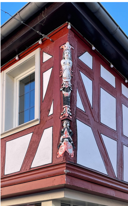
5.18 Detail eines Fachwerkhouses in Dieburg
