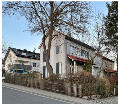
5.82 Neubau mit regionaltypischen Elementen in Groß-Bieberau
