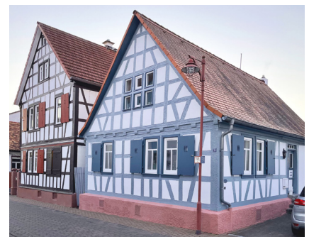
5.44 Fachwerkhäuser auf Steinsockeln in Groß-Bieberau
