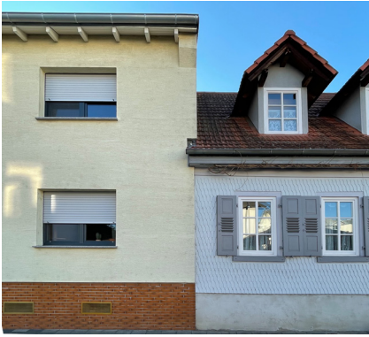
5.46 Ungleiche Nachbarn in Dieburg: Haus des 20. Jahrhunderts mit liegenden Fensterformaten und industriellen Bauprodukten (links) und historisches traditionell verschindeltes Fachwerkhaus mit stehenden Fensterformaten und handwerklicher Bauausführung (rechts)
