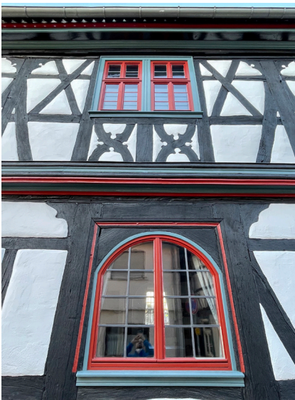
5.22 Ausschnitt der Fassade des Alten Rathauses in Roßdorf
