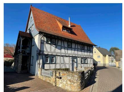
5.14 Denkmalgerechte Sanierung eines Fachwerkhouses in Eppertshausen
