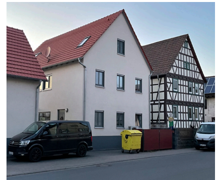
5.83 Eingepasster Neubau in Groß-Bieberau
