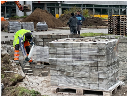
6.34 Ausbau und Palettierung von Betonpflaster
