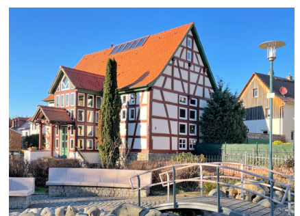
5.30 Moderner Umbau eines Fachwerkhäuses in Seeheim (Seeheim-Jugenheim)
