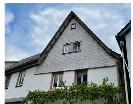
5.60 Saniertes historisches Wohnhaus in Richen (Groß-Umstadt)
