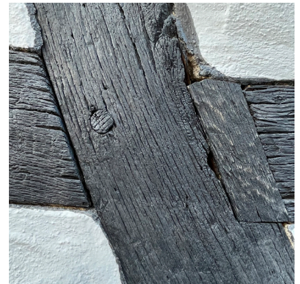
5.27 Detail: Fügung der Balken mit Holznagel am Alten Rathaus in Roßdorf
