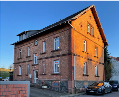
5.71 In der Region relativ selten anzutreffen: Wohnhaus in Backstein-Sichtmauerwerk in Nieder-Modau (Ober-Ramstadt)
