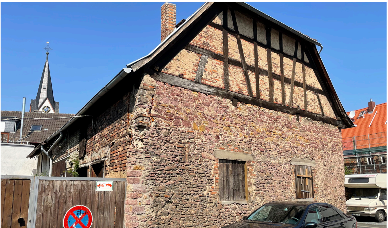
6.14 Verschiedene sichtbare Baumaterialien an einer Scheune in Weiterstadt-Gräfenhausen: giebelseitig gemischtes Bruchsteinmauerwerk unten mit Stahlblechstützen, darüber Sandstein-Buchsteinmauerwerk und am Giebel Fachwerk mit Backsteingefachen; traufseitig massives Klinkermauerwerk, Stahlträger
