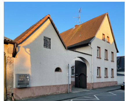
5.66 Hofreite mit Haupt- und Nebengebäude in Pfungstadt
