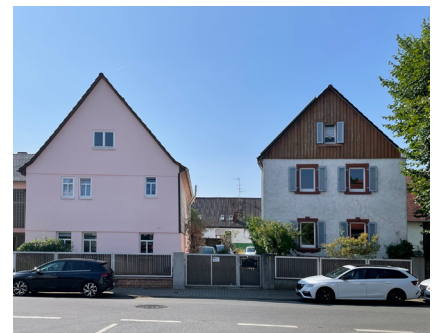
6.37 Wohnhäuser im Ortskern von Weiterstadt-Gräfenhausen
