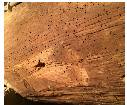
6.07 Biotischer Kreislauf: sichtbare Bohrlöcher der holzersetzenden Larven des gemeinen Nagekäfers (Holzwurm) in einem Tragbalken eines alten Fachwerkhäuses
