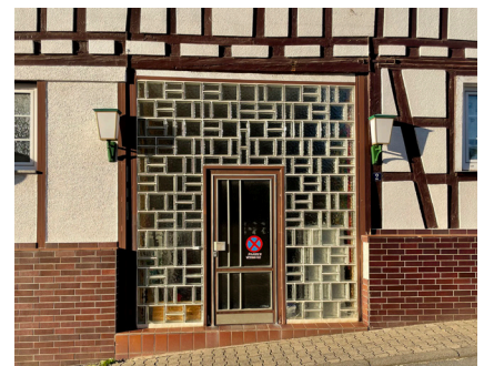
5.75 Entstellende Einbauten der 1960er Jahre in ein Fachwerkhäuser in Ober-Ramstadt
